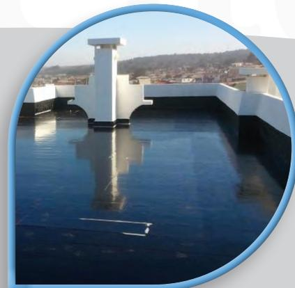
La résine HYPERDESMO-PB1K, est utilisée pour le traitement étanche des points de détails ou singuliers. La mise en œuvre s'effectue sans primaire, à l'extérieur comme à l'intérieur.
