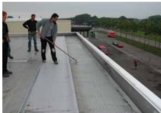
Fig. 2: Répartition de la colle d'une manière égale au moyen d'une brosse.
