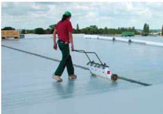
Fig. 1: Mise en place semi-automatique de la colle polyuréthane
