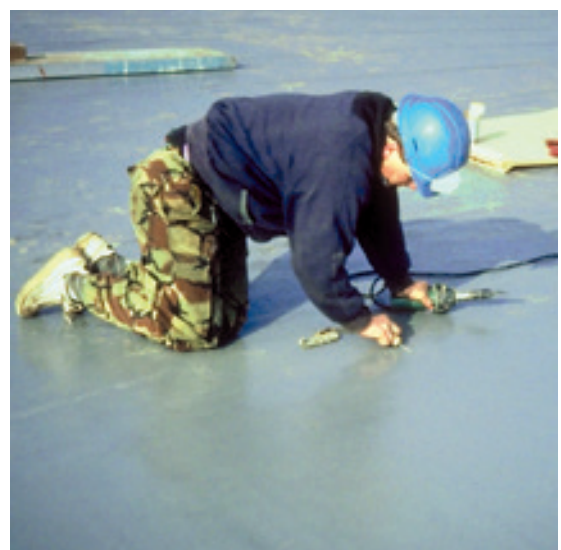
Fig. 2: Contrôle des soudures
